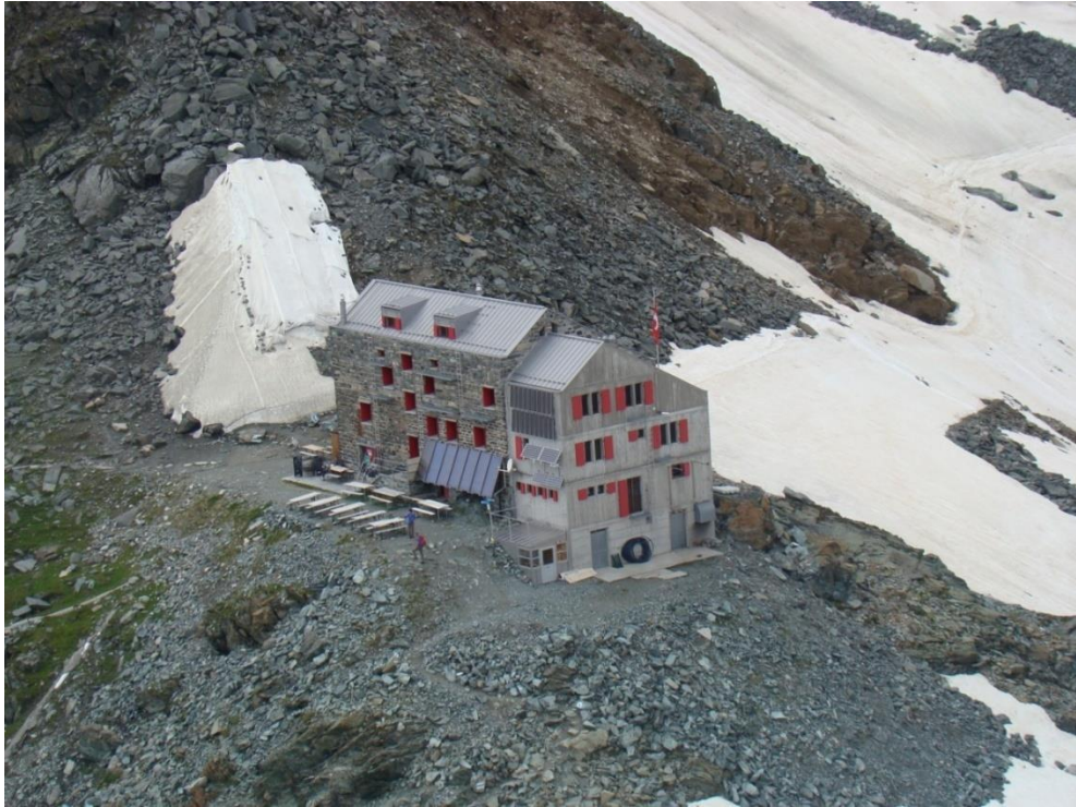
Obr. 1. Britanniahütte so zásobárňou vody pre chatu (snehové pole za chatou)
